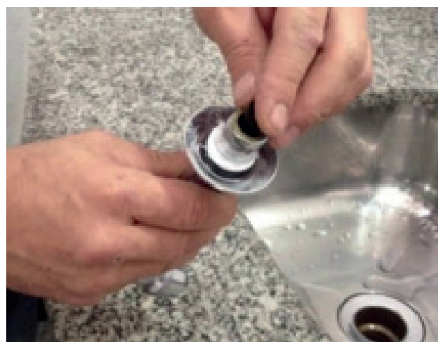
Preenchimento de questionários pela população (à esq.) e instalação de redutores de vazão (à dir.)
